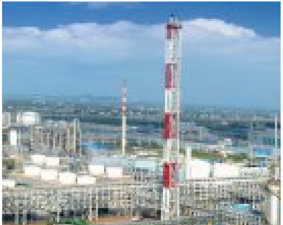
Die höhere Bildqualität der IP-Megapixel-Kameras von Arecont Vision IP ist ein wichtiger Faktor bei der Bereitstellung des optimalen Perimeterschutzes in der großen BASF-Anlage.
